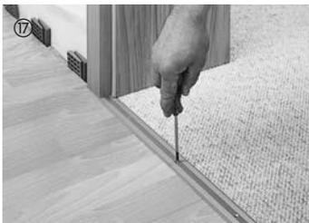
In der Schiene ist ein Dehnungsabstand von ca. 5 mm einzuhalten. Grundsätzlich müssen Holztürstöcke in Bodenelementdicke mit einer Feinsäge abgeschnitten werden, damit der Laminatboden eine Dehnungsmöglichkeit hat.
