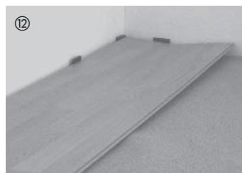
Erst wenn die gesamte Reihe stirn- und längsseitig verbunden ist, kann sie von links nach rechts abgesenkt werden.
